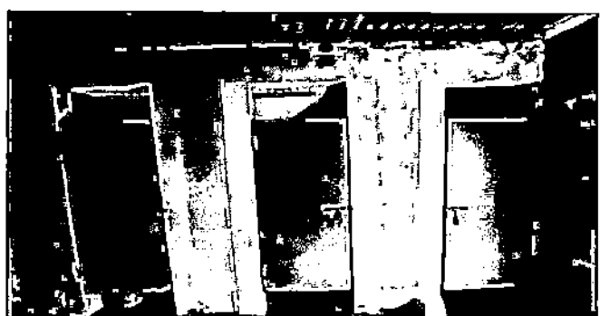
FOTO 6: Mantenimiento a estructura (lijado, cambio de tubo , cepillado, sujeciones, aplicación de pintura) a puertas servicios sanitarios
